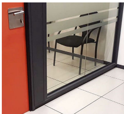
Fig. 6: vidrio laminado como paramento separador de un despacho.
