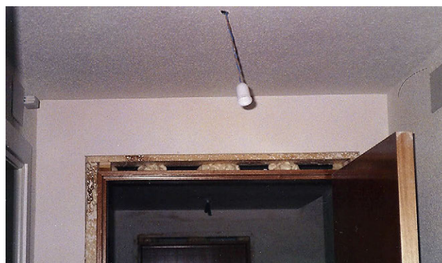
Fig. 1: acuñaado entre el marco de una puerta y su precerco.
