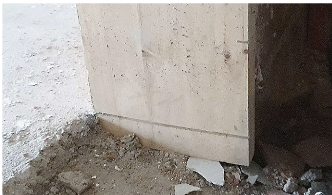
Fig. 5: detalle de la entrega del larguero de un precerco de puerta, con empotramiento bajo la capa de compresión del solado realizada con mortero de cemento.
