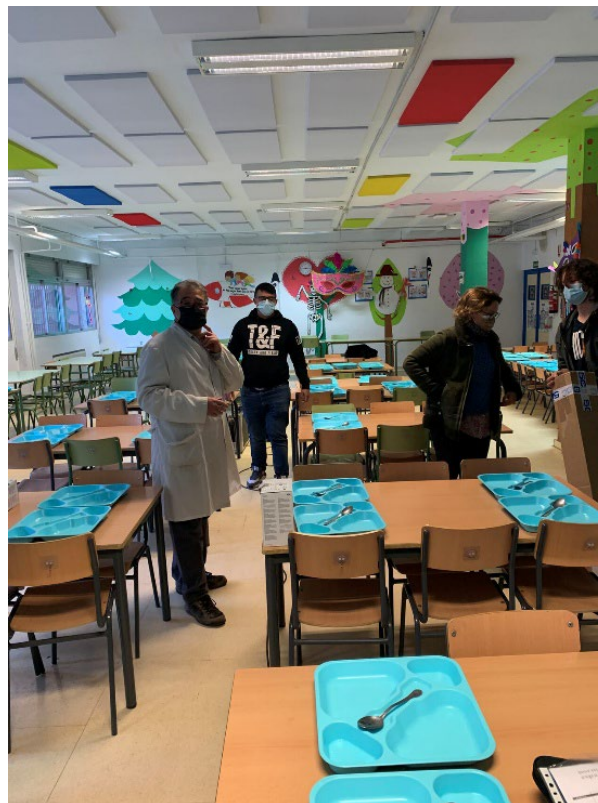
Figura 2: Preparación de los ensayos en el comedor reformado del colegio. El tiempo de reverberación inicial de 1,81 seg. disminuyó con las medidas adoptadas a 0,78 seg.
