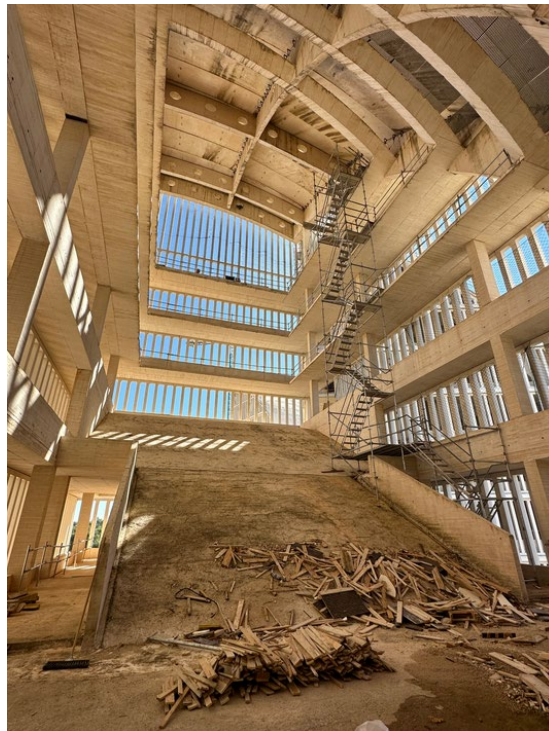
Figura 4. Cúpulas de la energía, Garrañeta (Soria) (Fuente: GRUPO HERCE)
