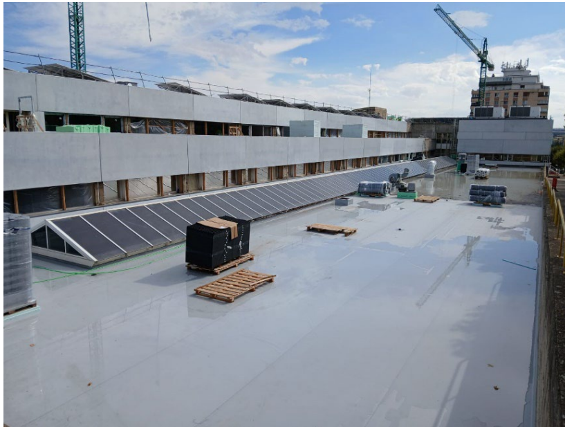
Figura 7. Vista de una cubierta aljibe del edificio. Fuente propia.
