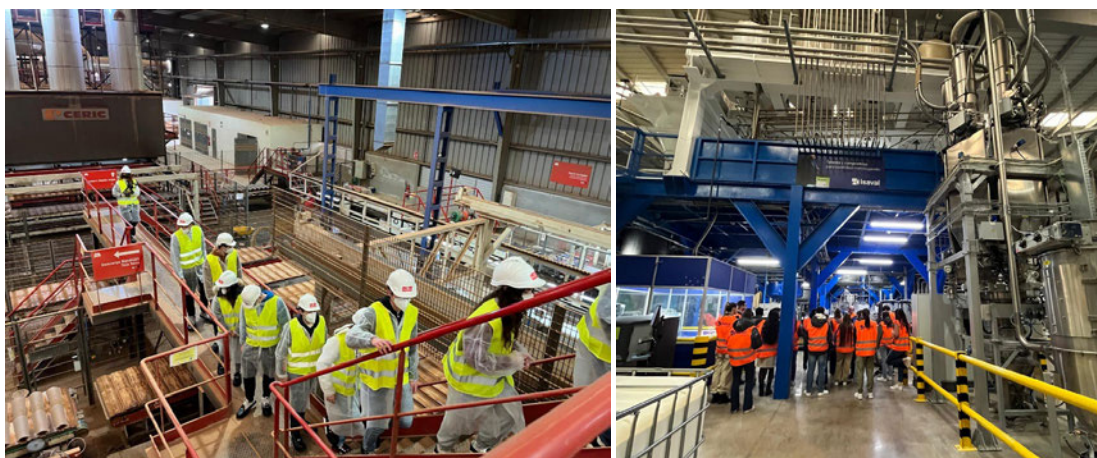
Foto 2. Aplicación laminas bituminosas in situ, visita de obra Tejas Borja (izda). Instalaciones Kerakoll (dcha). (Fuente propia).
