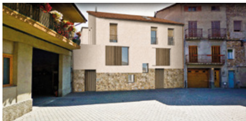
Rectoria de Montagut. Façana principal.
