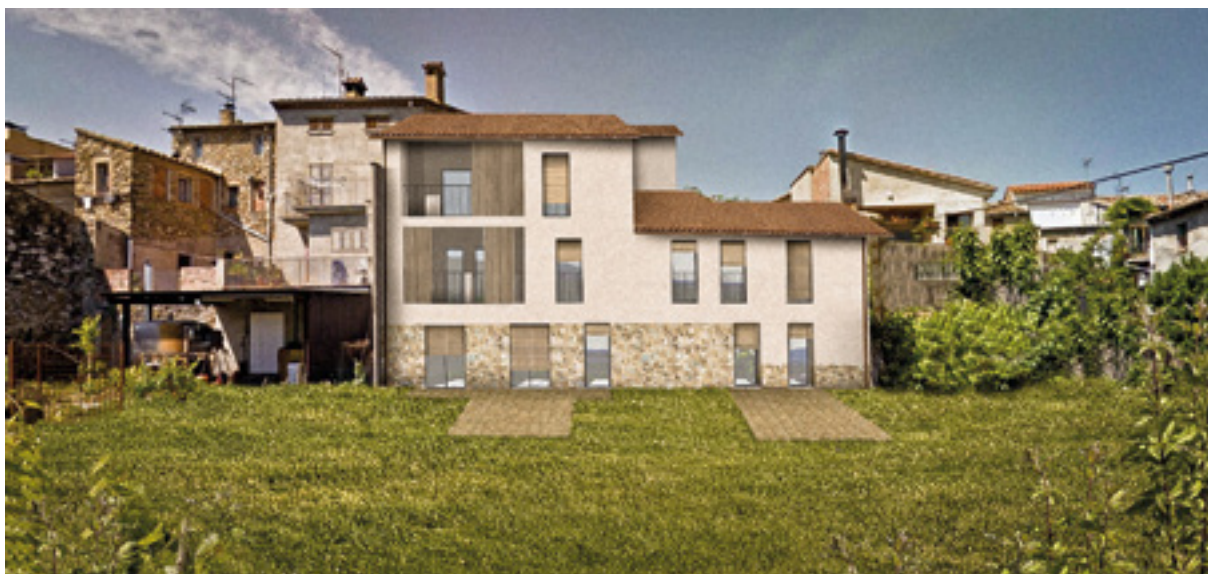
Rectoria de Montagut. Construcció de cinc habitatges.
