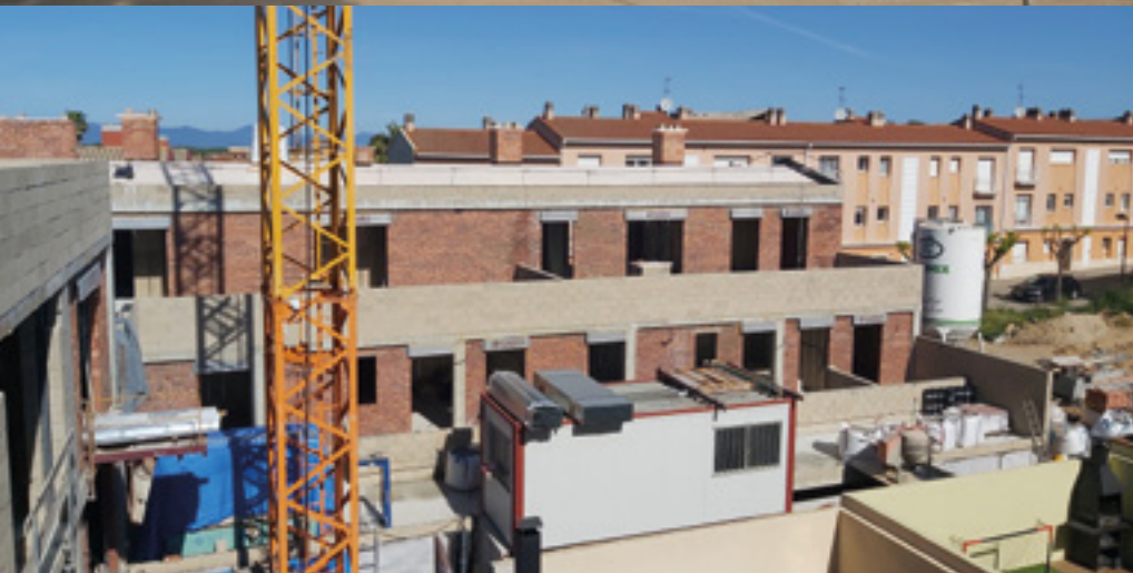
Diferents vistes de la construcció de l'edifici. Fotografies: Joana Argerich.
